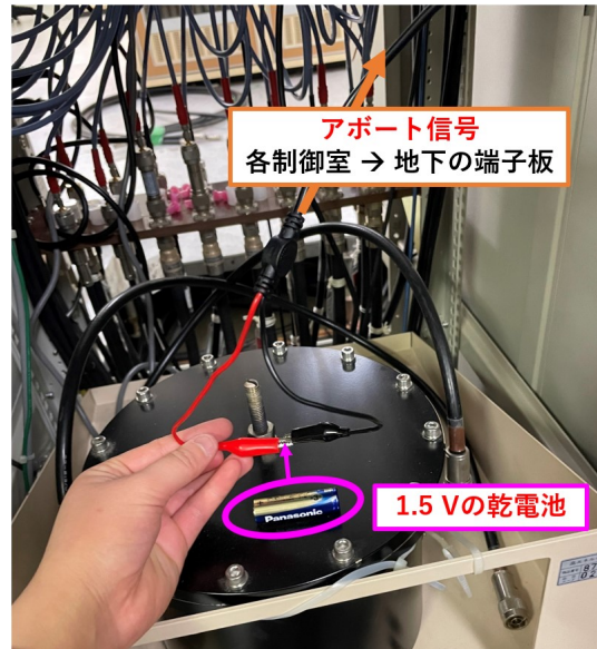
図 5.15: 疑似アボート信号を入力している様子
