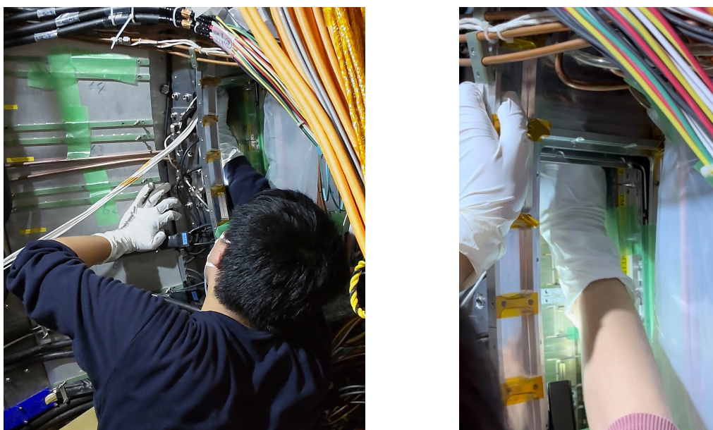
図 31 実機での HV ボード取り外し試験の様子。
