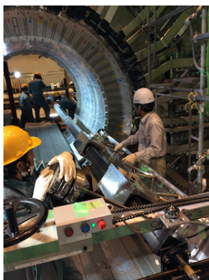
図 2.3: インストールの様子1。TOP カウンターをスロットに向けてスライドしている様子。
